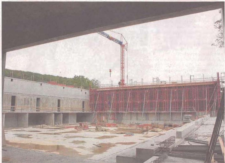
Die Bauarbeiten an der neuen Sporthalle in Ingelfingen sind in vollem Gang. 6,6 Millionen Euro wird das energetische Vorzeigebauobjekt kosten, das nach der Fertigstellung auch Künzelsauer Studenten zu Forschungszwecken nutzen können. Foto: Ralf Reichert
